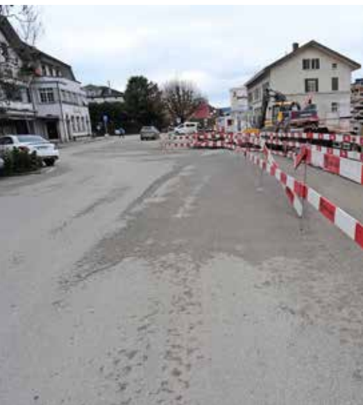
Baustelle Bahnhof Herzogenbuchsee; im Vordergrund der Bahnhofplatz, der neu gestaltet wird.
